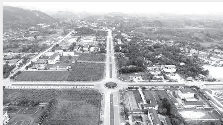
Tân Sơn tập trung nguồn lực đầu tư xây dựng và hoàn thiện kết cấu hạ tầng đô thị khu Trung tâm hành chính huyện tại xã Tân Phú, hướng tới trở thành thị trấn trong tương lai gần
