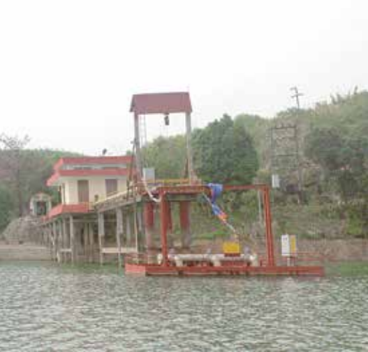
Trạm bơm đặt trên xà lan nổi trên mặt hồ Thác Bà - Sáng kiến kinh nghiệm giúp cho doanh nghiệp vận hành và sản xuất nước ổn định, an toàn
