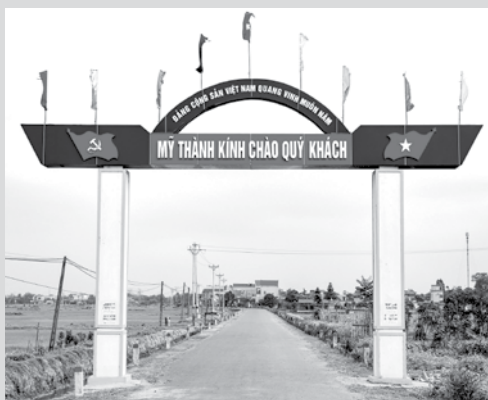
Đường giao thông xã Mỹ Thành, huyện Mỹ Lộc được trải nhựa phẳng tấp thuận tiện cho việc đi lại và trao đổi hàng hóa.
