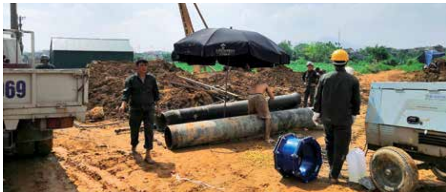
Cán bộ, công nhân viên Công ty CP Cấp thoát nước Tuyên Quang đẩy nhanh tiến độ thực hiện dự án cấp nước sạch cho nhân dân
