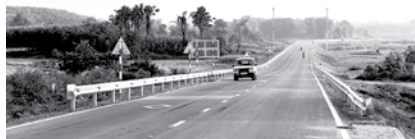
Đoạn đường Hồ Chí Minh đi qua xã Thái Long (TP Tuyên Quang) được đầu tư xây dựng, đáp ứng nhu cầu đi lại và giao thương hàng hóa của người dân
