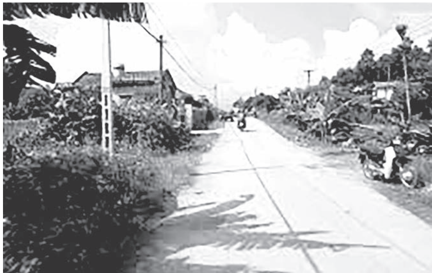
Đường giao thông nông thôn xã Tân Linh, huyện Đại Từ
