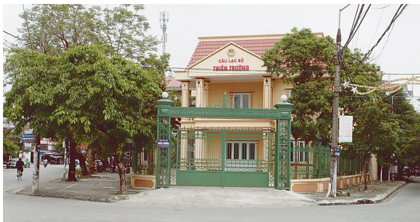
Trụ sở Câu lạc bộ Thiên Trường được sửa chữa, khang trang (Công trình được Công ty CP Xây dựng, PT nhà Vạn Xuân triển khai, hoàn thành đúng tiến độ)
