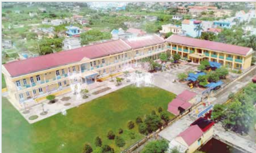
Trường mầm non xã Giao Nhân, huyện Giao Thủy, Nam Định
