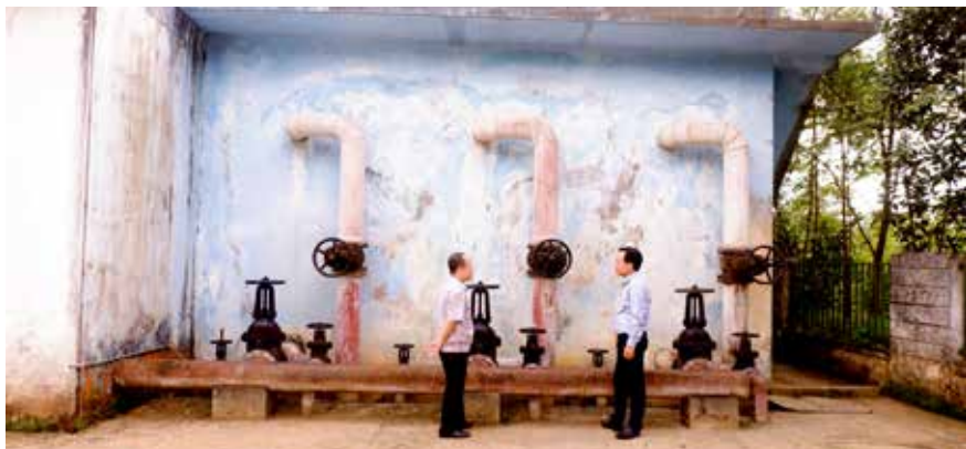
Thăm quan khu điều hành Nhà máy sản xuất nước sinh hoạt thị trấn Mậu A, huyện Văn Yên
