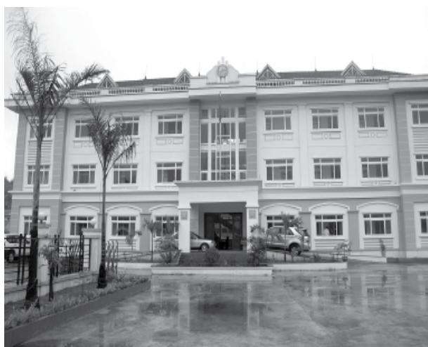
Trụ sở Cục Thống kê tỉnh Lào Cai
