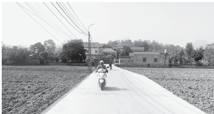
Công trình đường giao thông nông thôn tại xã Hoàng Tung, huyện Hòa An được đầu tư xây dựng rộng rãi, đáp ứng nhu cầu phát triển kinh tế - xã hội của địa phương
