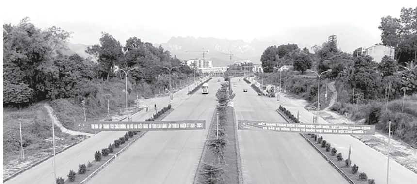
Tuyến đường phía Nam, Khu đô thị mới thành phố Cao Bằng là trục đường quan trọng kết nối 3 trung tâm đô thị lớn của Thành phố
