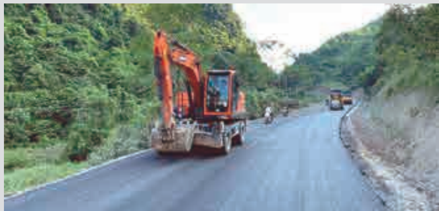
Tuyến Quốc lộ 3B đoạn qua phường Xuất Hóa (TP. Bắc Kạn) được thi công đảm bảo tiến độ và chất lượng
