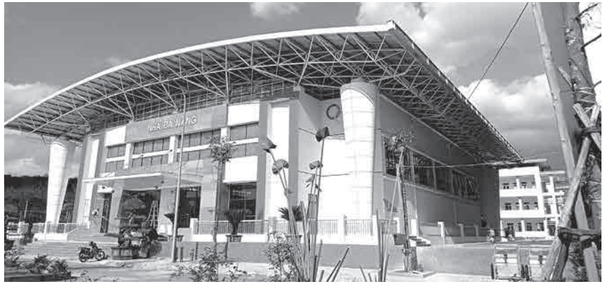
Công ty nhà thi đấu đa năng Liên đoàn lao động tỉnh Lai Châu được Trung tâm kiểm định chất lượng xây dựng
