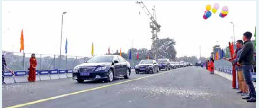
Cầu Kỳ Cùng do Sở Giao thông Vận tải tỉnh làm chủ đầu tư - Công trình tạo điểm nhấn quan trọng trong cấu trúc đô thị thành phố Lạng Sơn
