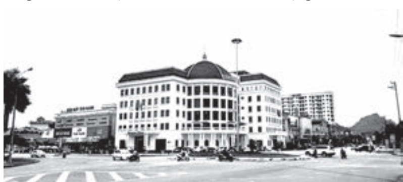
Diện mạo mới ở Trung tâm thương mại dịch vụ bờ trái sông Đà (Dự án được Trung tâm phát triển quỹ đất tỉnh đầu tư hạ tầng kỹ thuật)
